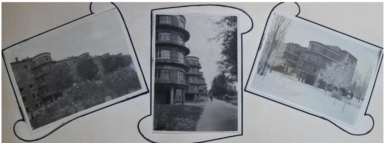
Рисунок 57 - Відновлення гуртожитку №1, 1945-46 рр (фото з натури)
