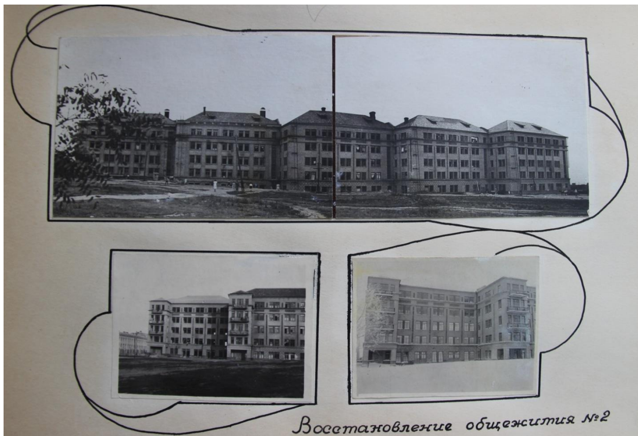
Рисунок 58 - Відновлення гуртожитку №2, 1945-46 рр (фото з натури)
