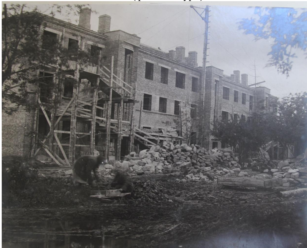
Рисунок 22 - Будівництво житлового будинку №3 для викладачів, 1932 р. (фото з натури)
