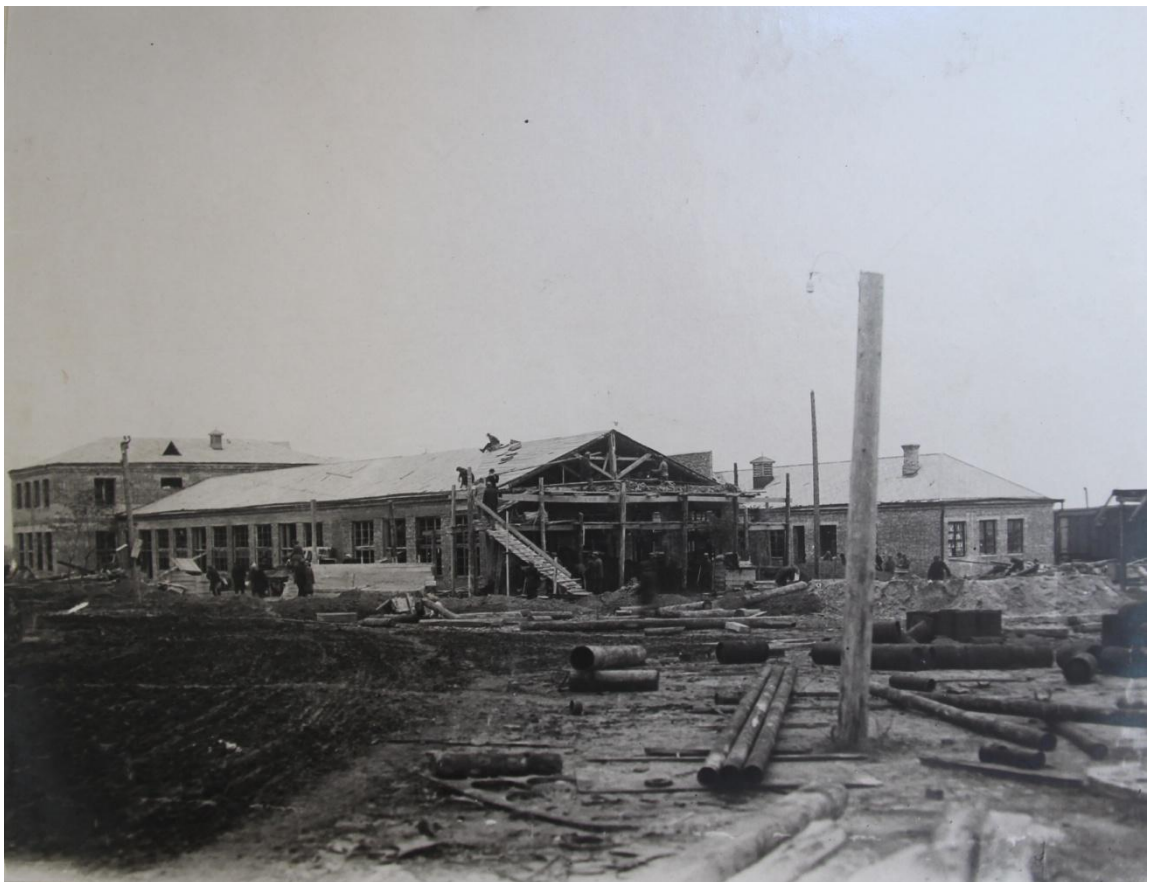
Рисунок 25 - Будівництво навчальних майстерень, 1932-33 р (фото з натури)
