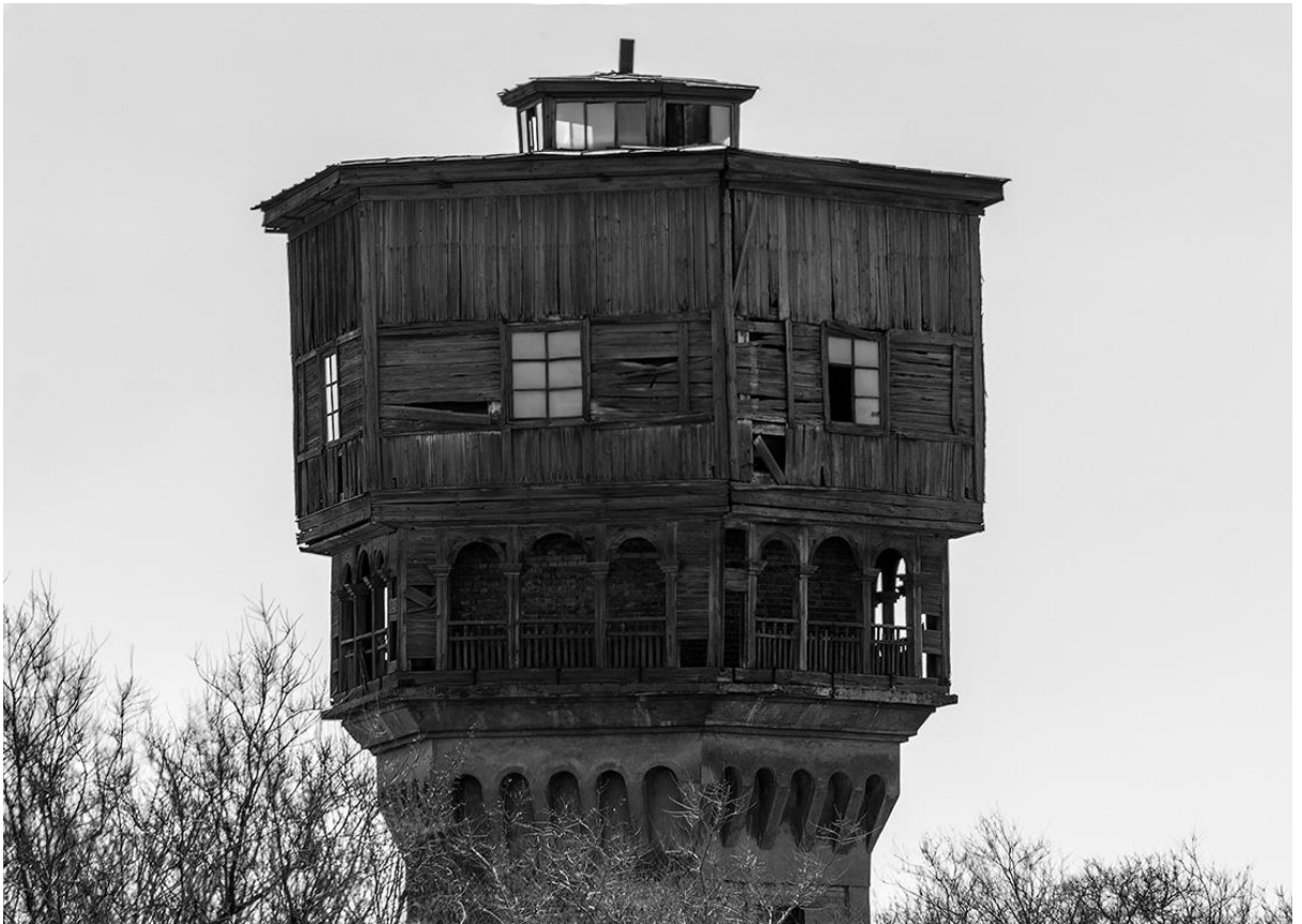
Рисунок 72 - Верхня частина водонапірної башти, сучасний стан дерев'яних конструкцій, 2015 р. (фото з натури)
