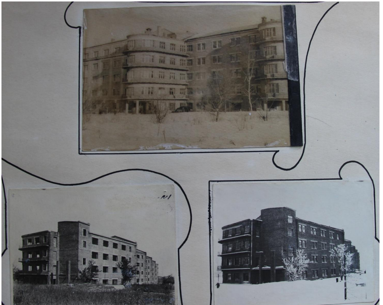
Рисунок 56 - Відновлення гуртожитку №1, 1945-46 рр (фото з натури)
