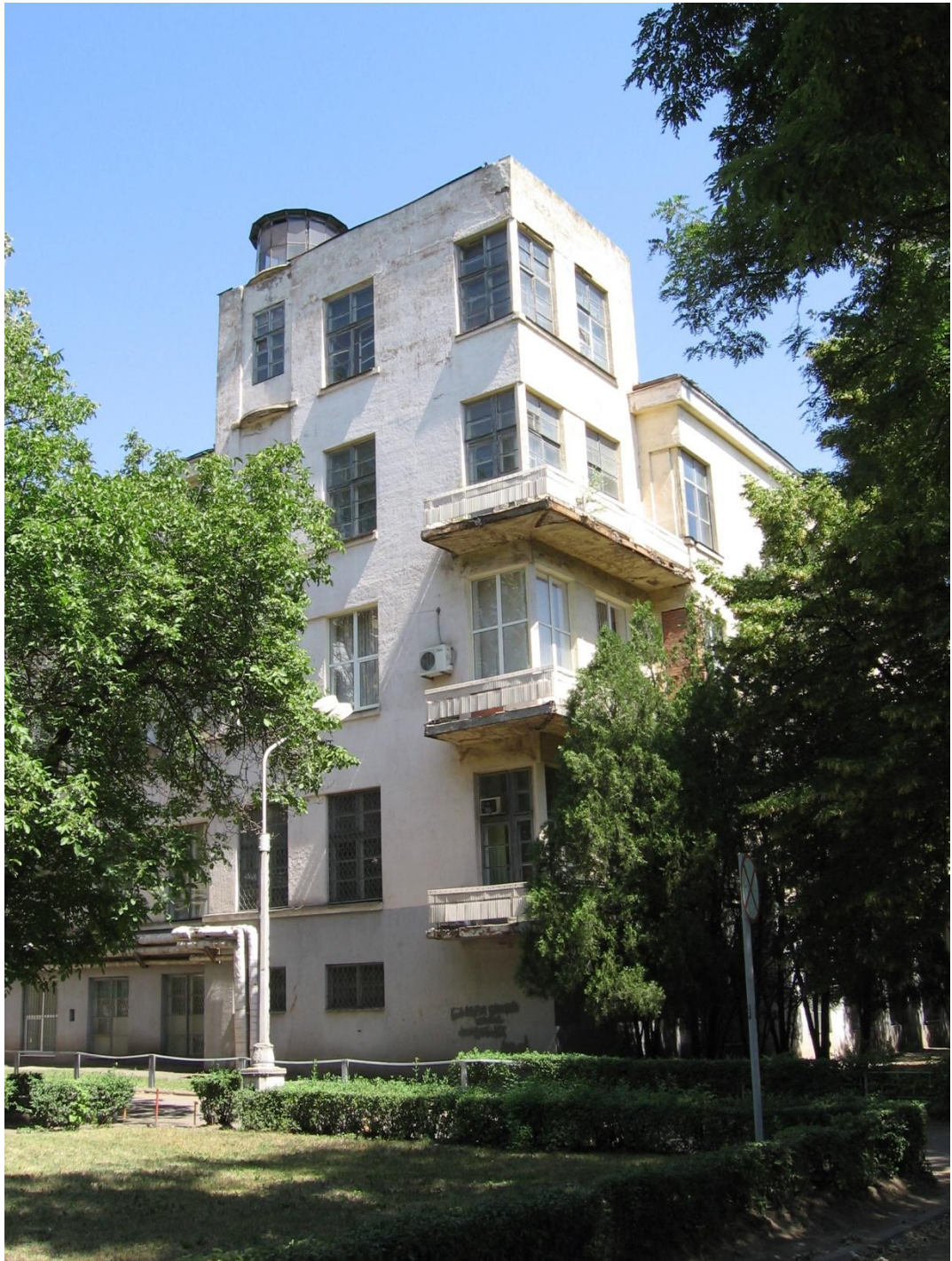
Рисунок 9 - Металургійна академія, Дніпропетровськ 1929-1931 р., арх.. Г. Швецько-Вінецький (фото з натури)
