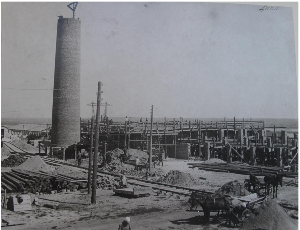
Рисунок 27 - Будівництво котельної, 1932-33 р (фото з натури)
