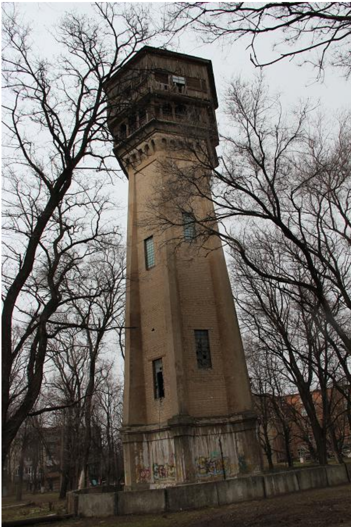
Рисунок 31 - Водонапорна башта, сучасний вигляд (фото з натури, 2014 р)
