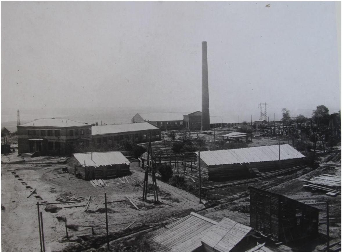
Рисунок 26 - Будівництво навчальних майстерень, 1932-33 р (фото з натури)
