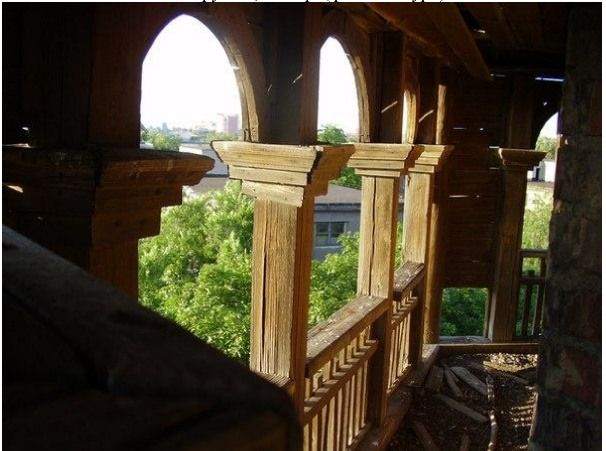
Рисунок 73 - Галерея водонапірної башти, сучасний стан дерев'яних конструкцій, 2015 р. (фото з натури)
