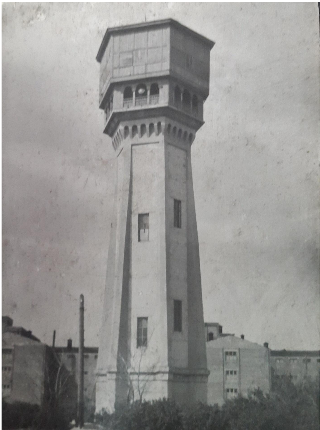
Рисунок 30 - Водонапірна башта, 1933 р (фото з натури, 1937 р)
