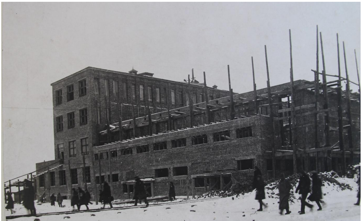
Рисунок 13 - Будівництво навчального корпусу, 1932 р (фото з натури)
