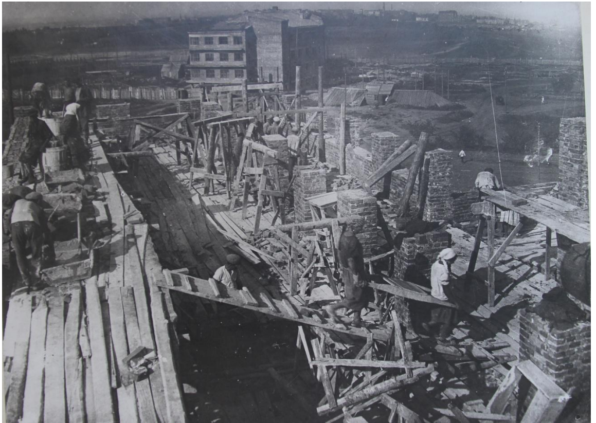
Рисунок 14 - Будівництво навчального корпусу, 1932 р (фото з натури)
