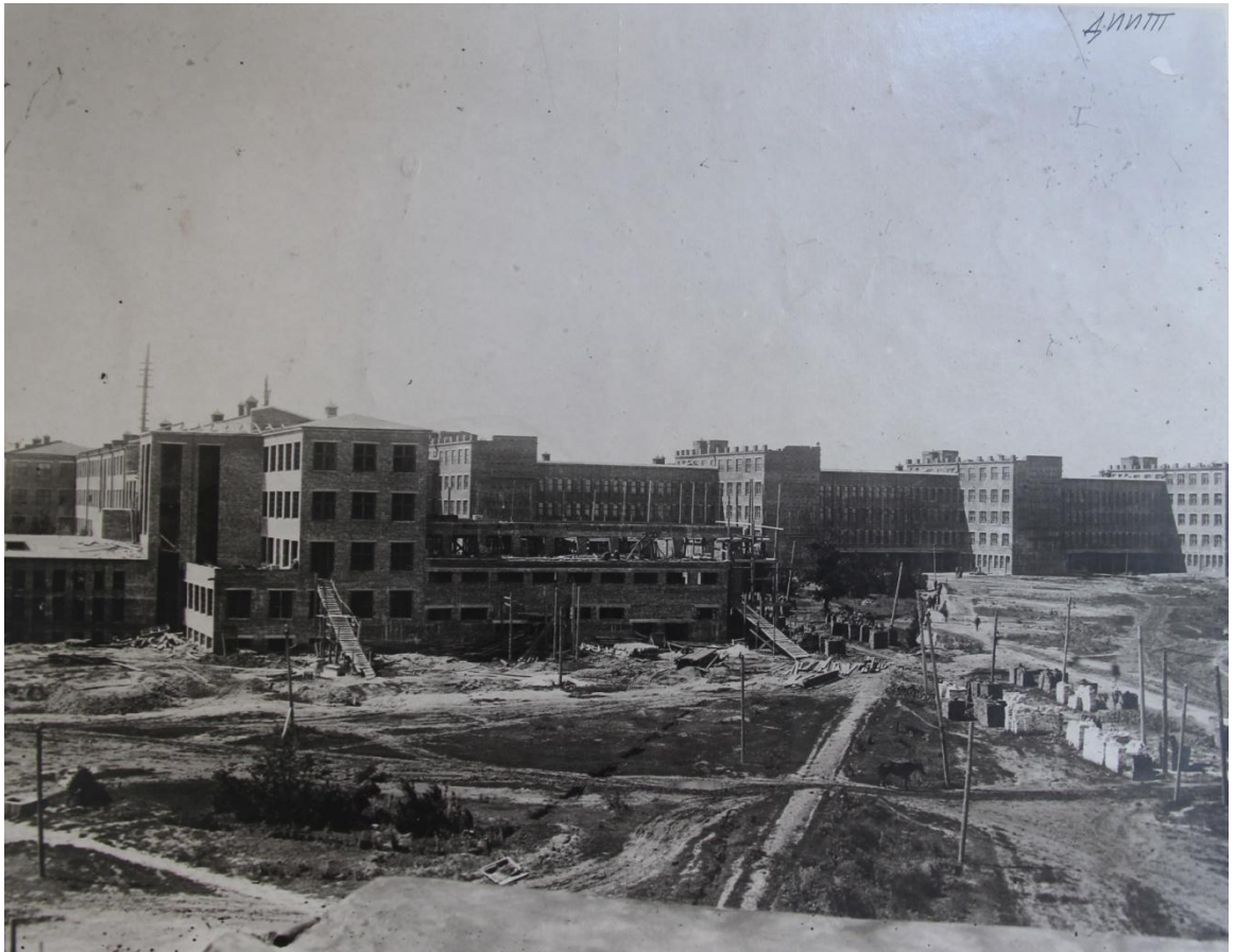
Рисунок 10 - Будівництво навчального корпусу, 1932 р (фото з натури)
