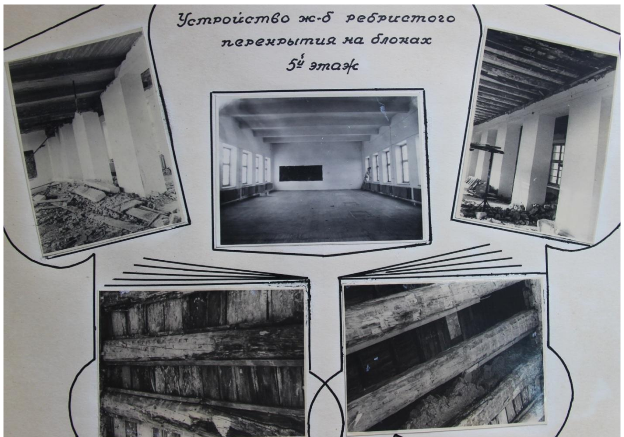
Рисунок 55 - Улаштування залізобетонного перекрыття по балках, 1947-49 рр. (фото з натури)
